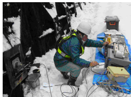
写真-2 試行探査状況
