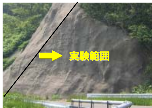
写真-1 実験対象の吹付のり面と実験範囲
