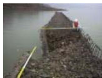
写真 3.1② 地震による側壁崩壊
