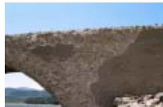
写真 3.1① 側壁の剥離状態
