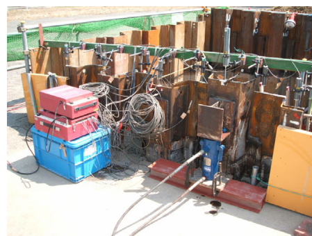
写真-3 引抜実験状況
