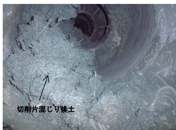
写真－4 スクリュコンベヤ内の状況
