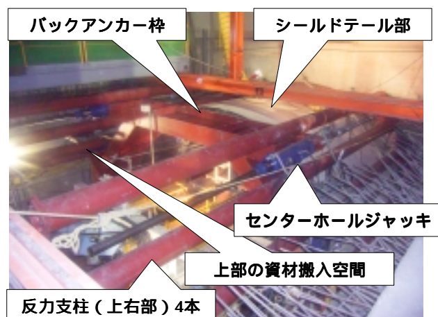
写真-1 往路の本発進方法とシールド地山貫入状況
