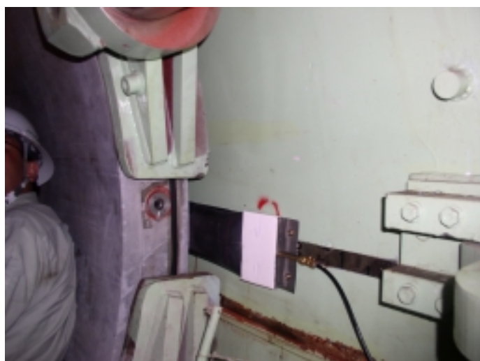
写真-2 テールプレートとセグメント間の袋体
