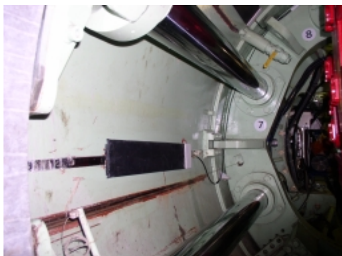
写真-1 袋体取付状況
