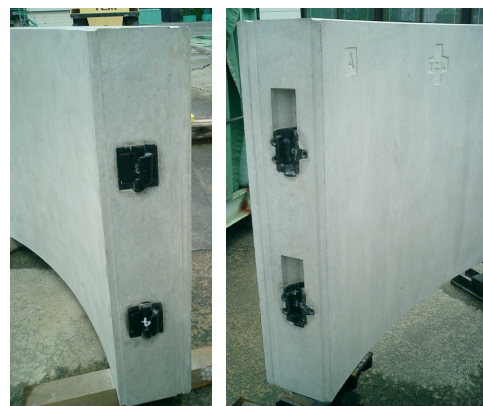
図-6 セグメント継手状況
