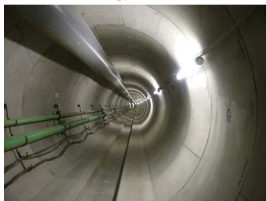
写真2 RCセグメント組立完成写真
