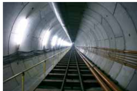
写真-4 トンネル坑内全景
