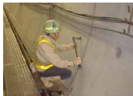
写真-3 WW継手増締状況
