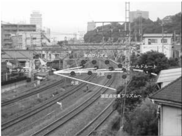
写真 - 1 JR常磐線測点位置及び計測状況
