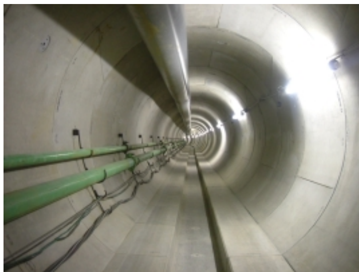
写真-1 掘進完了状況
