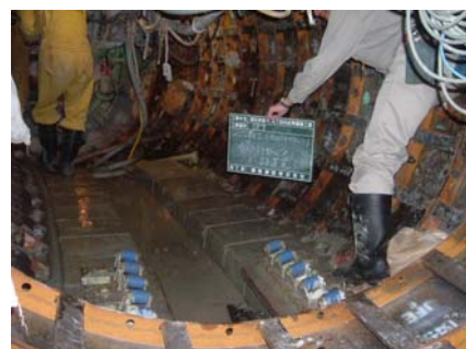
写真-6 設置完了
