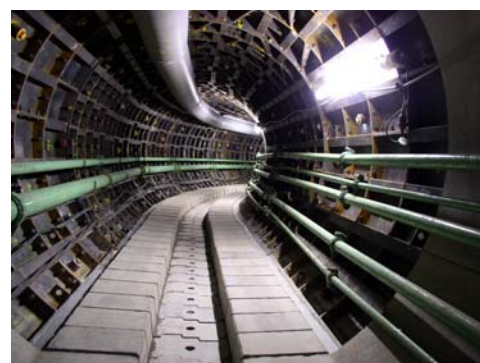
写真-1 インバートブロック設置状況
