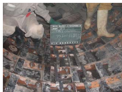
写真-3 平鋼設置状況
