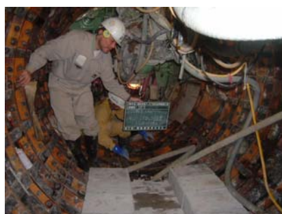
写真-4 エアチューブ挿入状況
