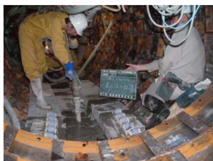
写真-5 充填材注入状況
