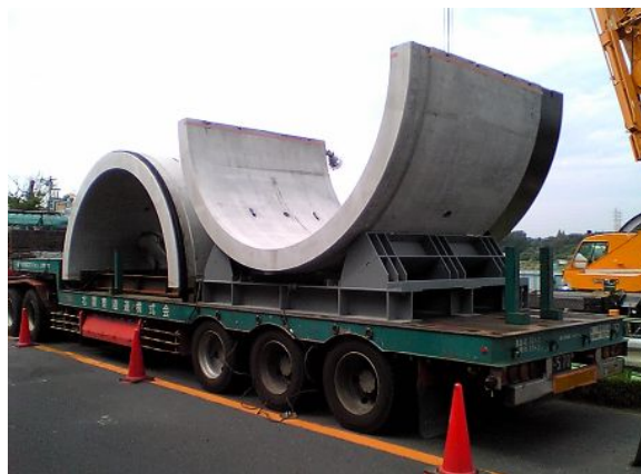
写真-2 推進管輸送状況
