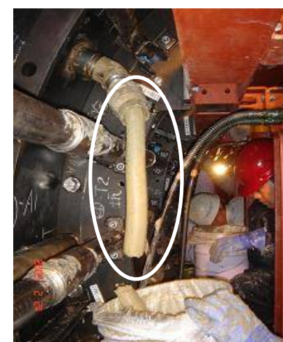
写真-1 充填材回収状況 （実証施工時）
