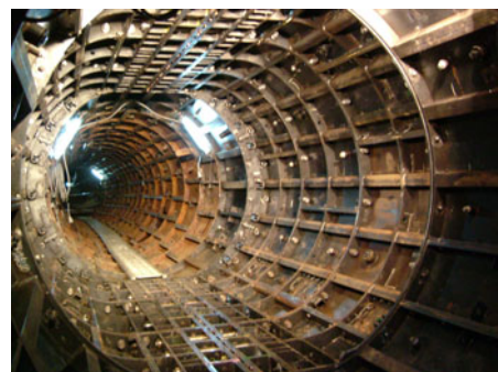
写真－1 実証施工状況（拡幅後断面）
