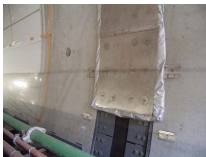
写真-2 耐火工設置状況
