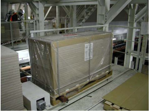
写真-1 耐火板搬入パッケージ
