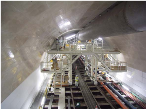
写真-2 耐火板施工台車
