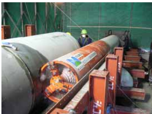
写真-1 切削実証試験実施状況
