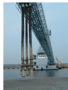
写真-1 ポンプ式打設船の簡先
