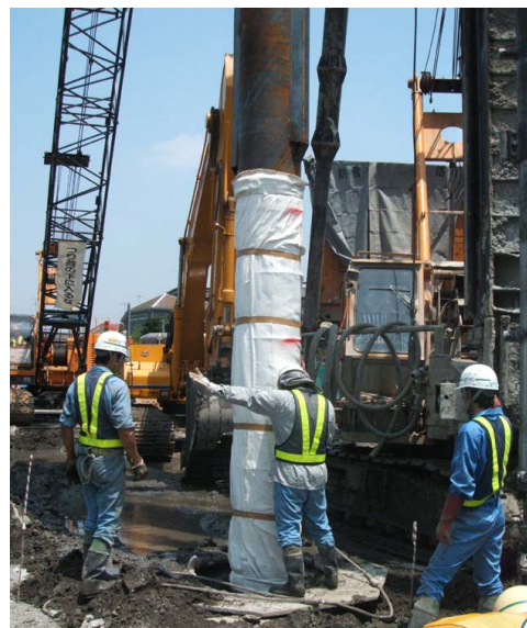
写真2 ハイブリッドパイルの施工
