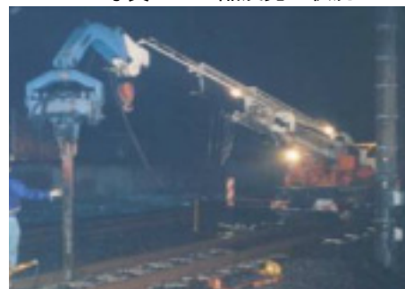
写真-2 強制沈下工法
