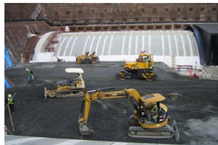
写真-3 CSG 敷均し・転圧状況
