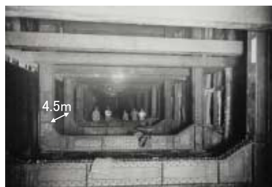
写真-1. 銀座線地下躯体鉄骨框構造（建設時）
