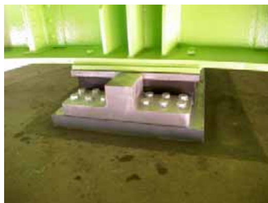
写真3 取替え後の支承
