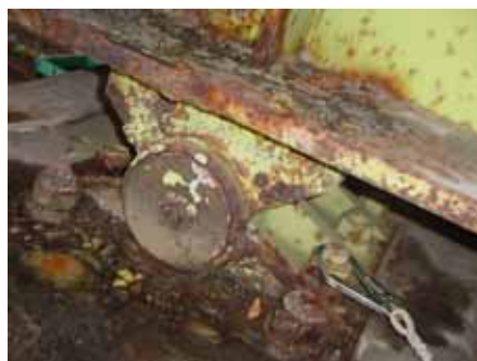
写真 1 支承の腐食
