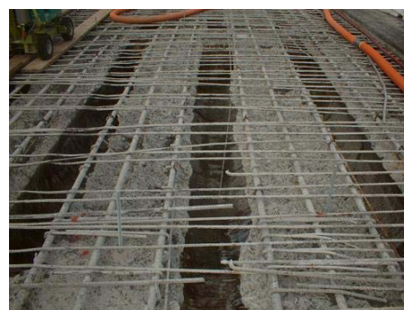
写真-3 WJ はつり完了後の状況
