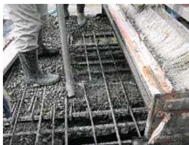
写真-1 鉄筋輻輳部での吸引
