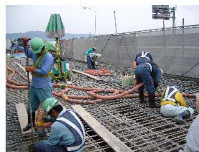
写真-2 ボイド部の吸引状況
