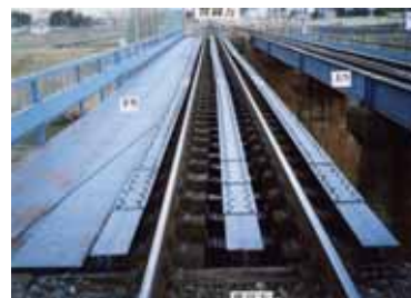
写真-1 補強前の橋桁全景
