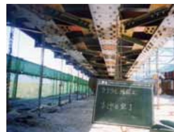
写真 - 6 ラテラル設置状況
