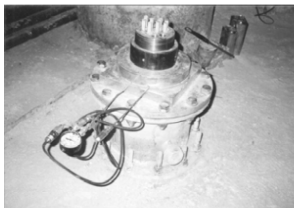
写真-1 ロードセル設置状況
