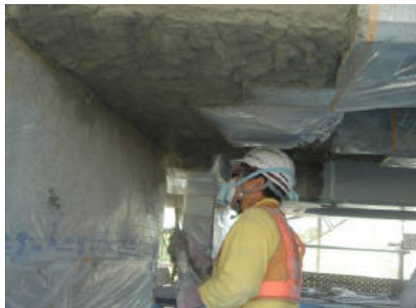
写真 - 2 吹付け ECC 施工状況
