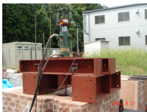
写真-1 アンカー引抜き試験状況
