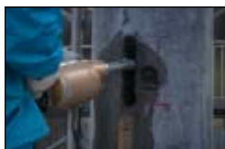
写真－2 C P削孔
