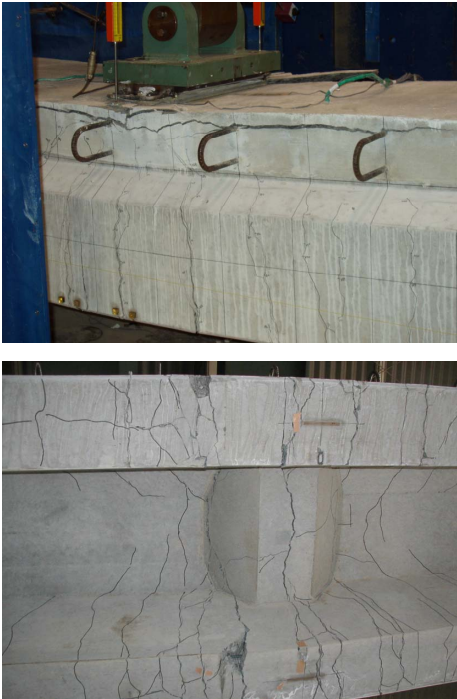
写真-3 単体供試体クラック発生状況
