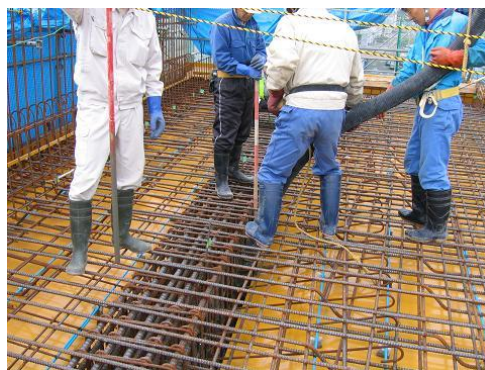
写真-3 R1 スラブ施工状況
