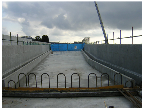
写真-4 R1 スラブ施工完了
