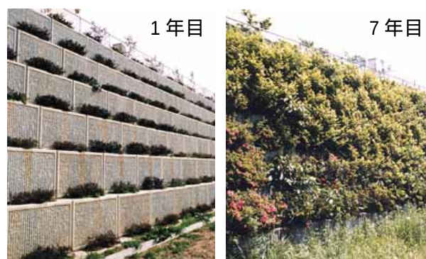
図2 大型中空ブロックによる緑化
