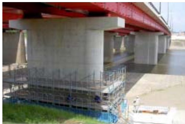
写真-2 大分県白滝橋での試験施工
