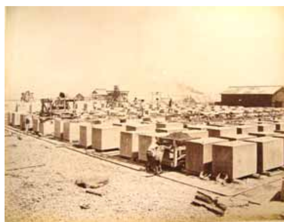
写真-2 コンクリートブロックの打設と養生 (函館どつく社提供)
