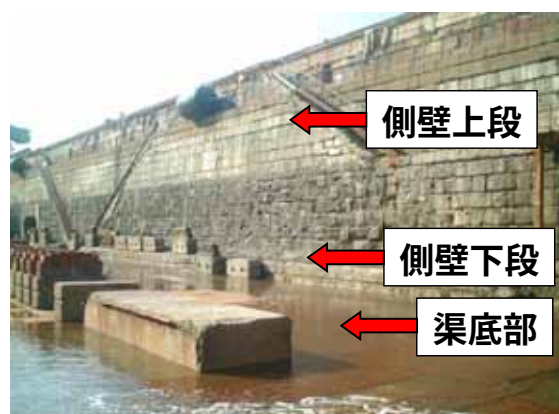
写真-1 Dockの外観とコア採取箇所
