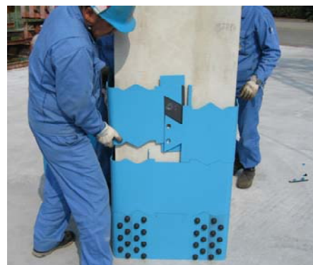
写真1 鋼板組立状況
