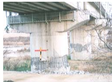
写真－1 橋脚段落し部の被害状況
