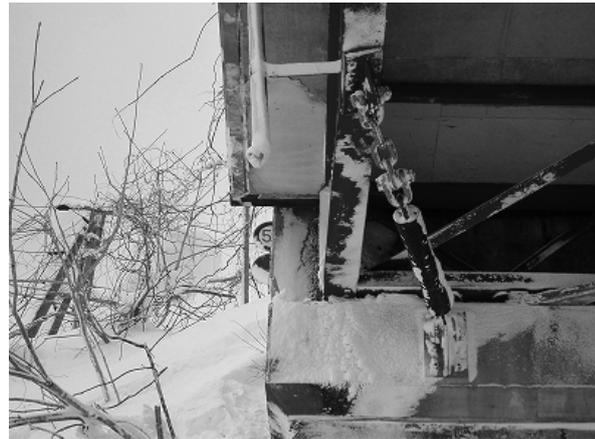
写真-1 雪崩直後の落橋防止構造
