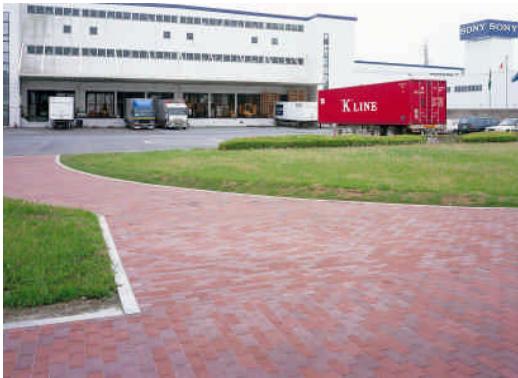
写真-2 施工状況（舗設直後）
