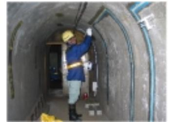
写真2 導電塗料施工状況
