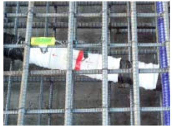
図-3 タグおよびセンサ付シースの設置状況
