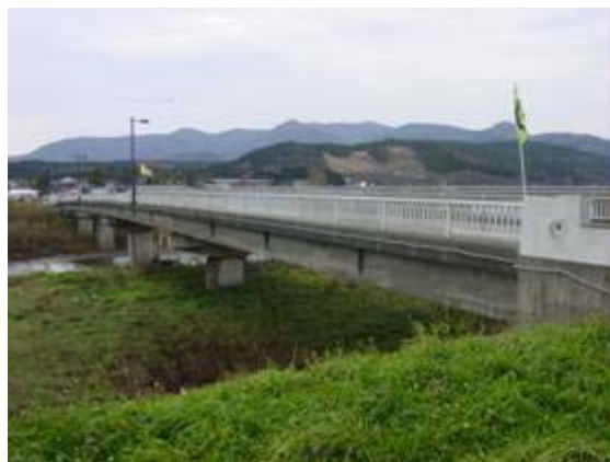
写真-1 対象橋梁
