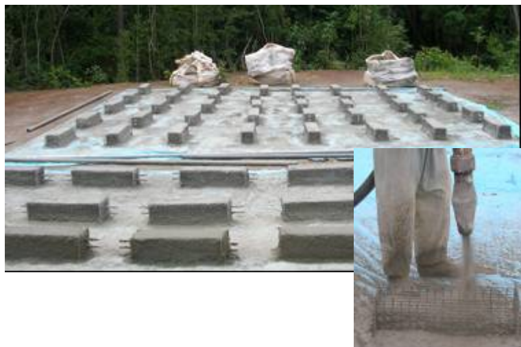
図 1 供試体作製状況
