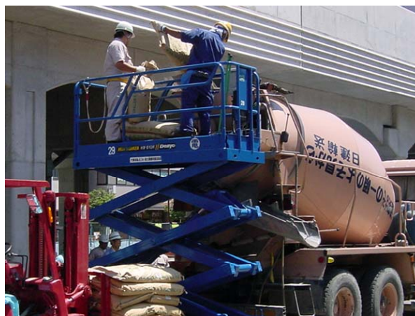
写真－1 PVA 繊維投入状況
