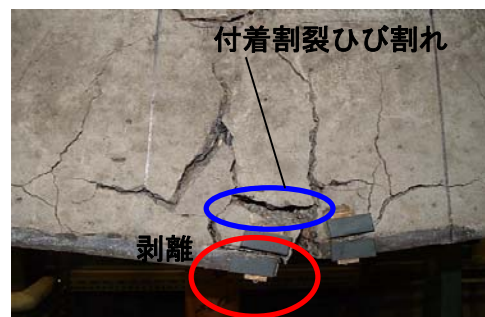
写真1 梁供試体の破壊状況
