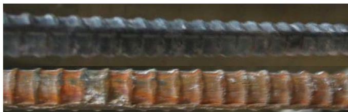
図6 載荷後の主筋(浸せき縁)
