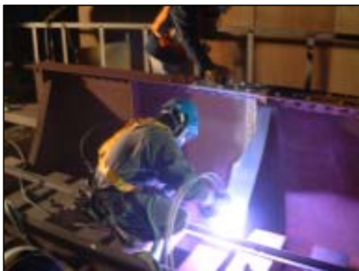
図-1 常温金属溶射
