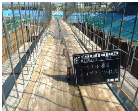
写真-1 パイプクーリング状況
