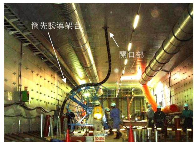
写真-3 筒先誘導架台使用状況
